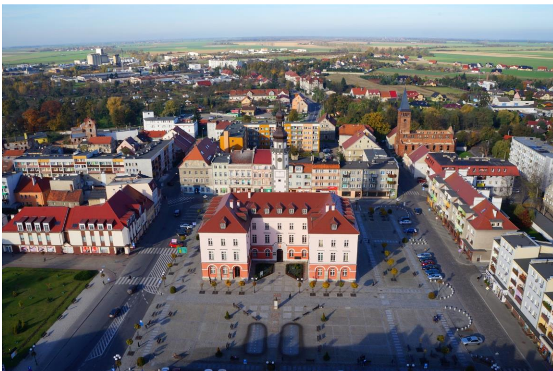
Zdjęcie 1. Rewitalizacja Ratusza w Grodkowie – adaptacja pomieszczeń na cele kulturalno-oświatowo-społeczne [Źródło: Urząd Miejski w Grodkowie]
