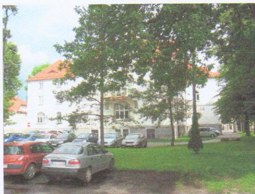
Elewacja tylna z wejściem do budynku
