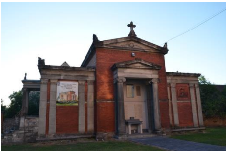
Fot. 28. Kopicze. Kaplica grobowa rodziny Schaffgotschów.
