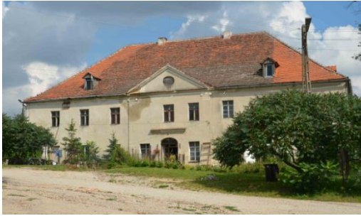
Fot. 19. Jeszkotle. Dwór.
