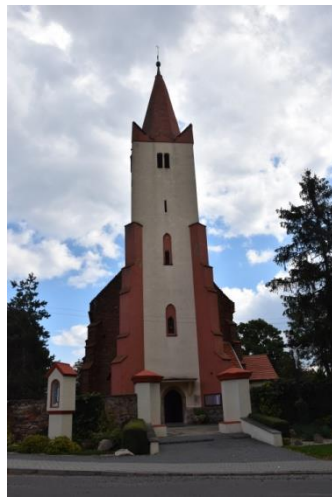
Fot. 29. Lipowa. Kościół pw. św. Marcina.
